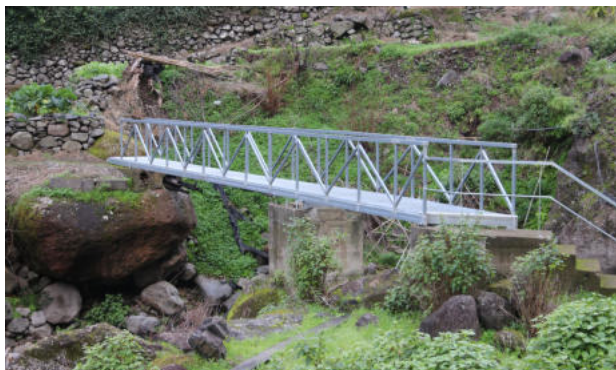
Colocação de pontes pedonais na Serra de Água
