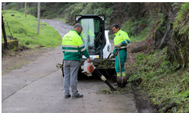
Limpeza da Estrada da Amexieira, Serra de Água
