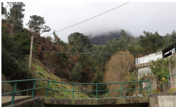
Reposição da tubagem de rega na Serra de Água
