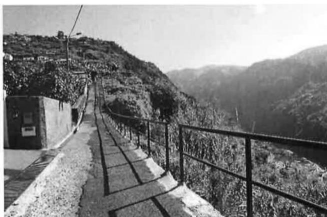
IMAGEM 7 – VEREDA APÓS COLOCAÇÃO DE GUARDAS METÁLICAS
