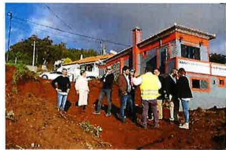
IMAGEM 2 – OBRA DE ALARGAMENTO DE VEREDA NA BOA MORTE
