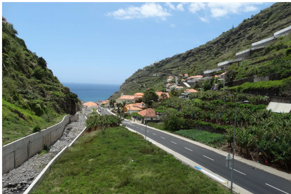
Figura 7 - Fotografia desde o viaduto da estrada regional 222
