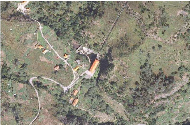
Figura 40: Central Hidroelétrica da Serra de Água.
