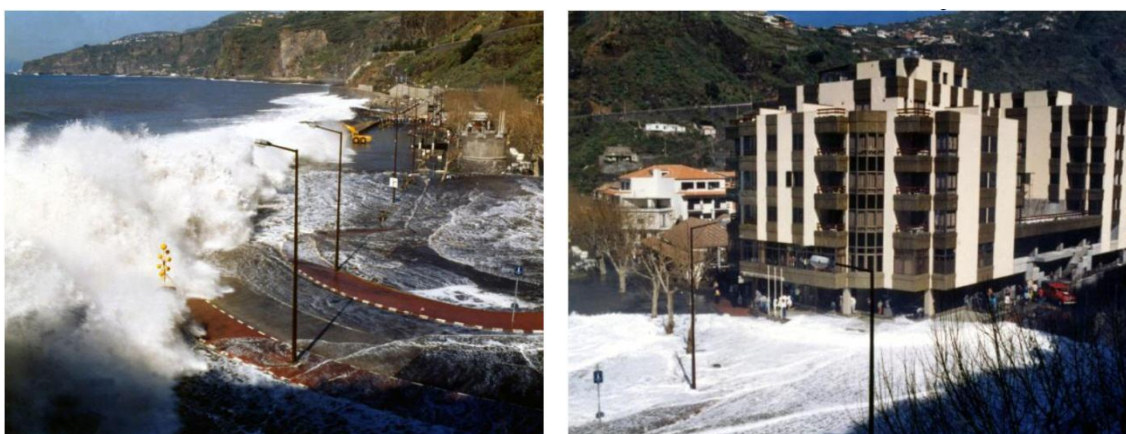
Figura 34 – Vila da Ribeira Brava em situação de galgamento e inundações costeiras (não datada). Retirado de Mariela F. (2009).
