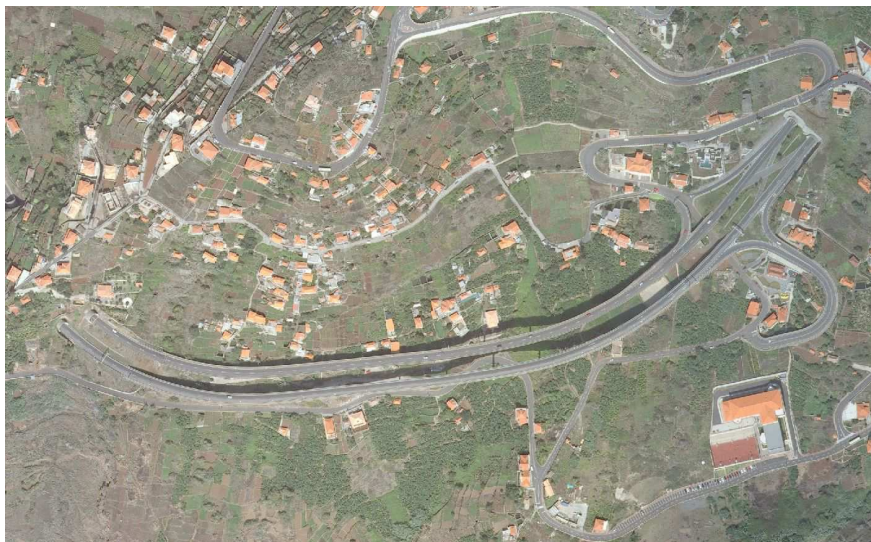
Figura 9 - Viaduto da Via Rápida – Campanário
