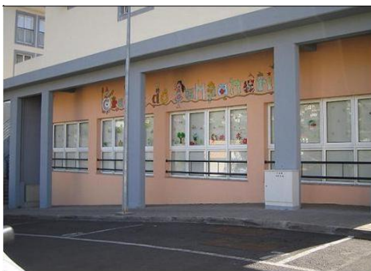
Imagem 7 - Instalações da Creche O Campanário
