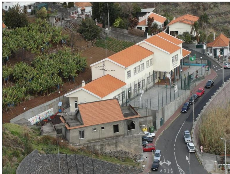
Imagem 10 - Instalações da EB1 com PE do Campanário
